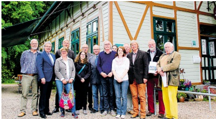
Viele Akteure und Kooperationspartner hat das Projekt „Erhalt der Baukultur“. Hier stehen einige von ihnen vor dem „Schweizer Haus“ in Tating, das im Rahmen des Projektes eine Außenrestaurierung erhielt. Das Gebäude, 1872 als Sommerhaus errichtet, ist in seiner Bauart das letzte erhaltene in Schleswig-Holstein. Seit 1998 beherbergt es ein Café-Restaurant. Foto: Tonio Keller
